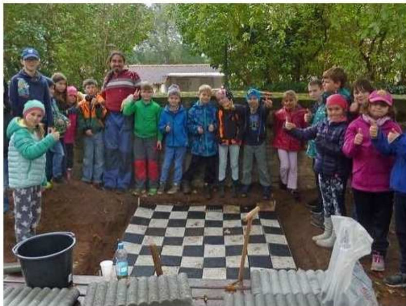
Halbzeit beim Spielfeldbau: Die Betonplatten sind verlegt, die Kinder mit dem Zwischenergebnis sichtlich zufrieden. Foto: Grundschule „Burg Ummendorf“
